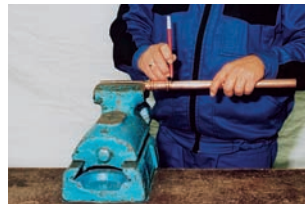
д) відмітити глибину вставляння;
